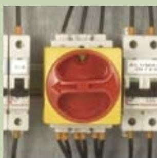
■ Versión empotrable que permite el seccionamiento de circuitos dentro del gabinete
